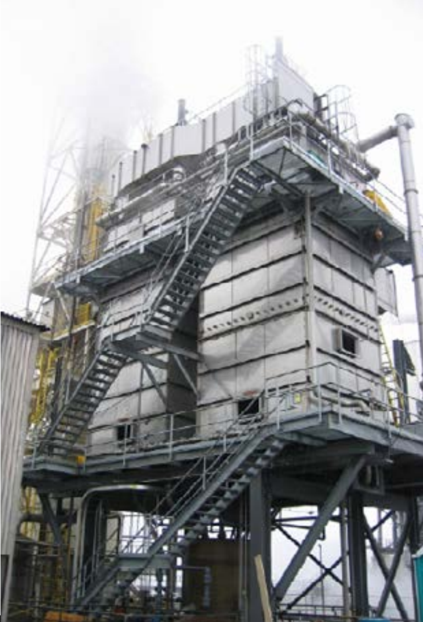
Electrofiltro Húmedo de Membrana para Aplicación de Caldera.
